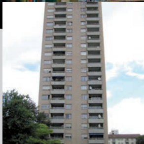
Hochhaus Schwandenholz, Zürich
